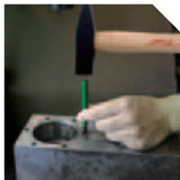
5. Utilizando a ferramenta de quebra, corte o pino na inserção
